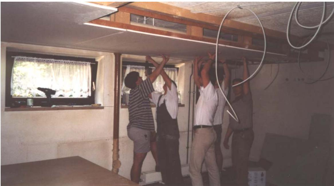
Zeitgleich waren die Sanitärinstallateure am Werk. Die bislang vorhandenen Rippenheizkörper mußten der geplanten Inneneinrichtung weichen. Von der Branddirektion wurden moderne und niedrige Flachheizkörper mit Thermostatregelung installiert.
